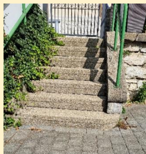
Hindernis Treppe für Rollstuhlfahrer/innen
